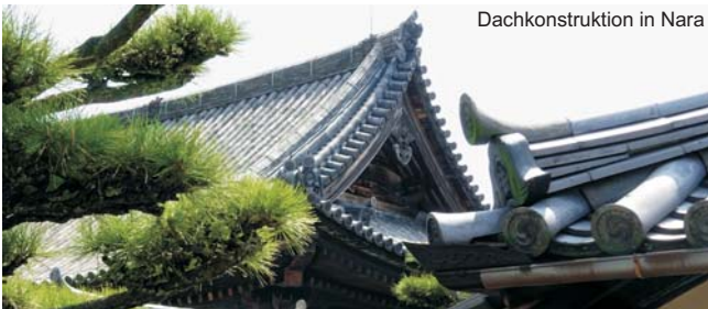
Dachkonstruktion in Nara
