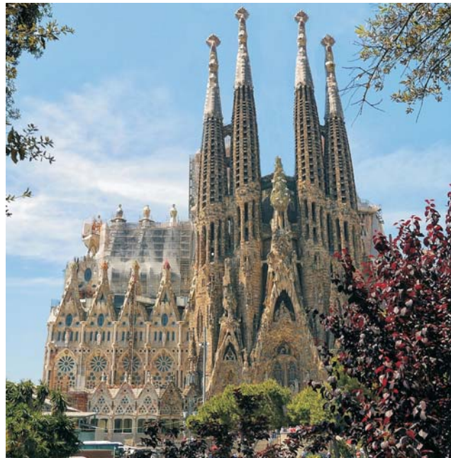
eines der vielen Wahrzeichen Barcelonas: die noch nicht fertige, aber begehbare Sagrada Família von Antoni Gaudí (Grundsteinlegung am 19. März 1882)
